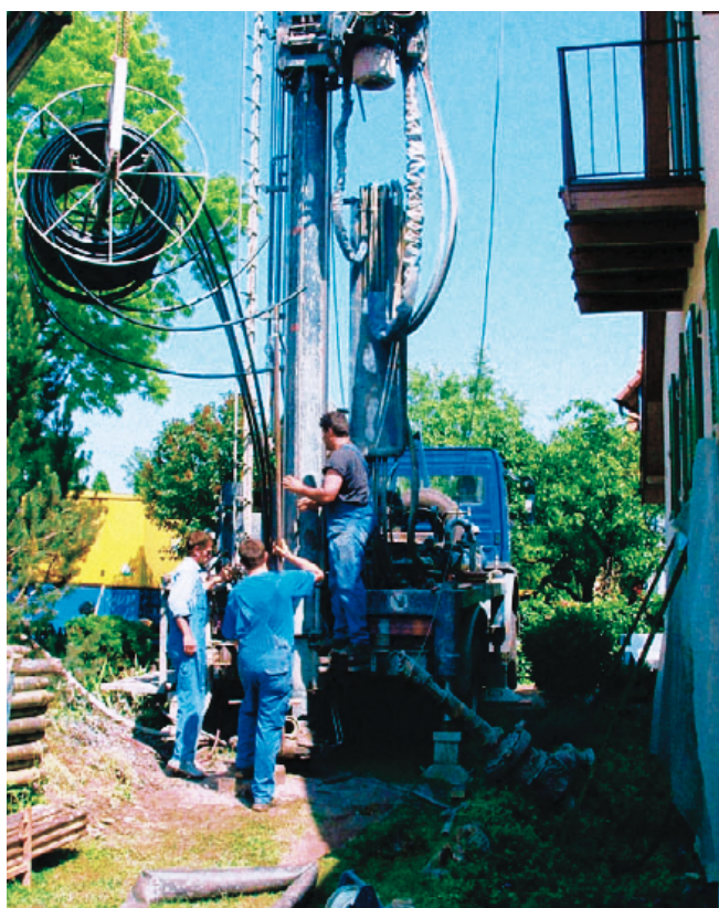
Bohrarbeiten für eine Erdwärmesonde an einem Einfamilienhaus.
