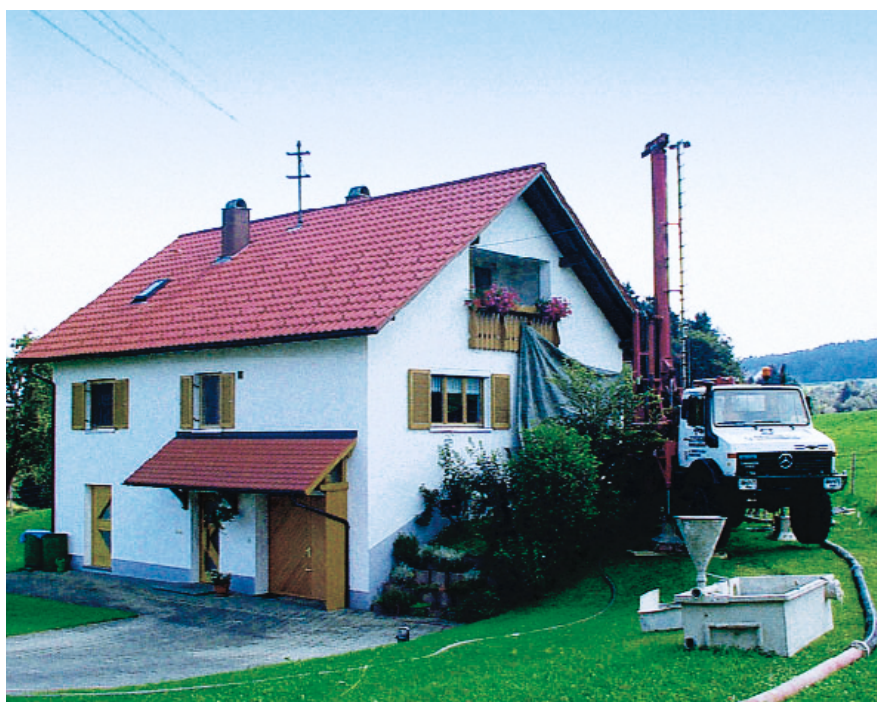
Bohrarbeiten für eine Erdwärmesonde an einem Einfamilienhaus.
